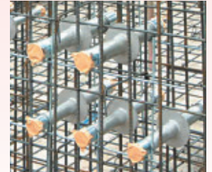
電線管スリーブ施工例
