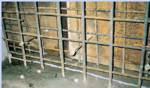
コンクリートの打ち継ぎ目に…
