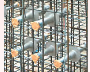
電線管スリーブ施工例
