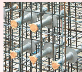
電線管スリーブ施工例
