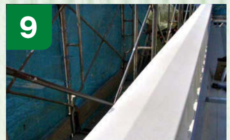
9 笠木を取り付け施工完了です。
