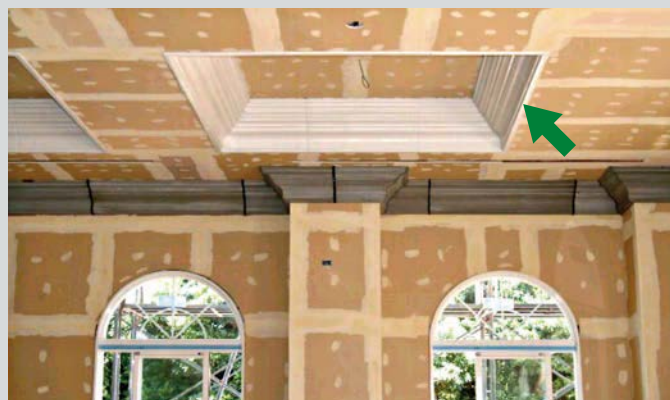
内装にもウォール・デコを採用。壁と天井の見切りボーダー、飾り天井。
