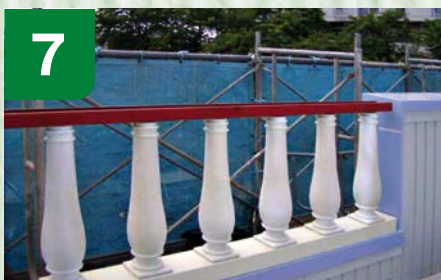
7 欄干ピンの上に笠木の下地材を取り付けます。
