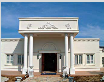
屋根ボーダー(ディンテル付)、勾配部と水平部の取り合いは、型枠では困難です。
