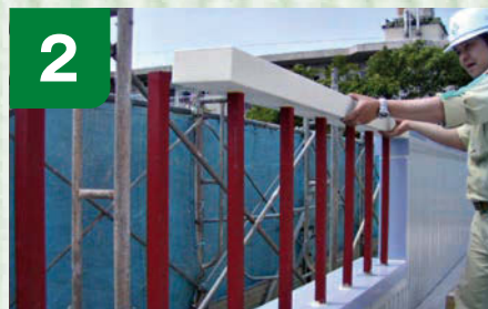
2 欄干の台座を取り付けます。
