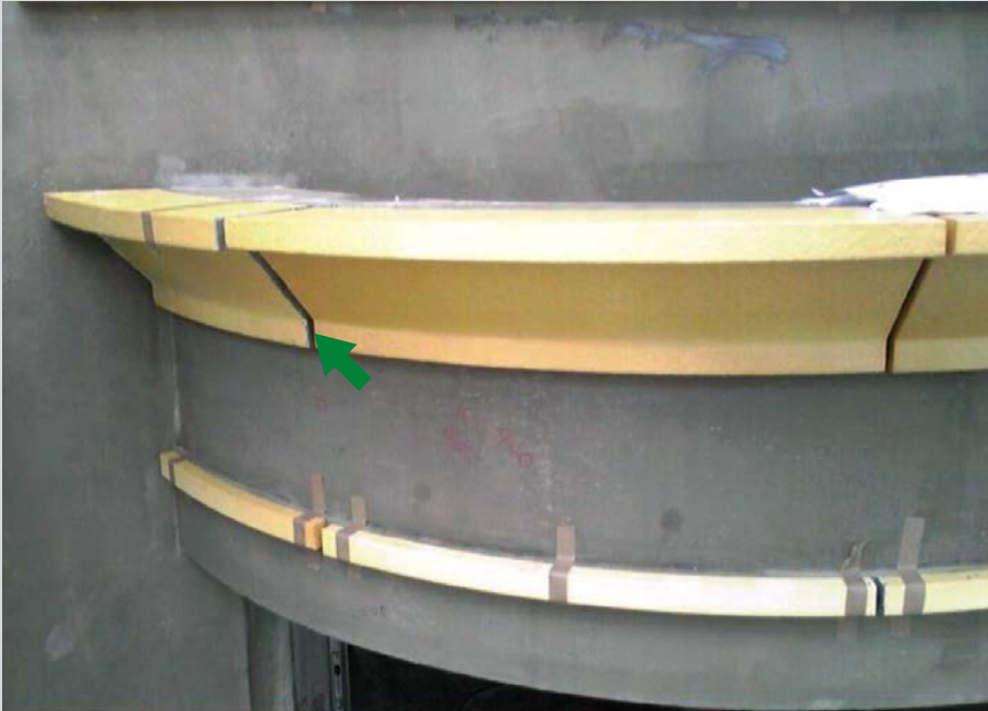
壁面のモール飾り、底部ボーダーの取付け画像です。製品同士の取り付け部にシーリング目地を設けます。
