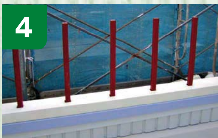
4 欄干台座の接続部および隙間には、コーキング処理をします。
