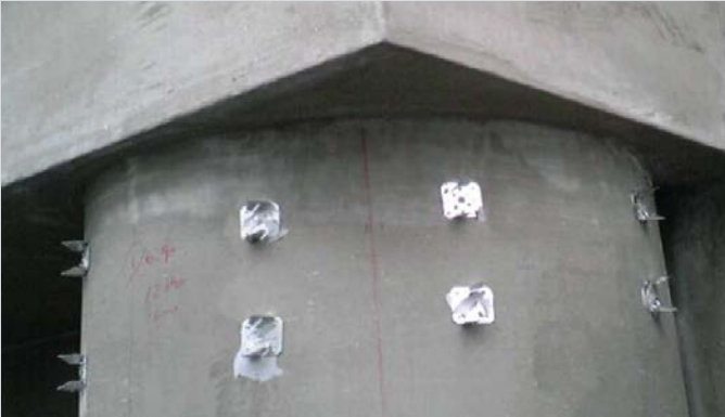
ウォール・デコアンカー取付け
