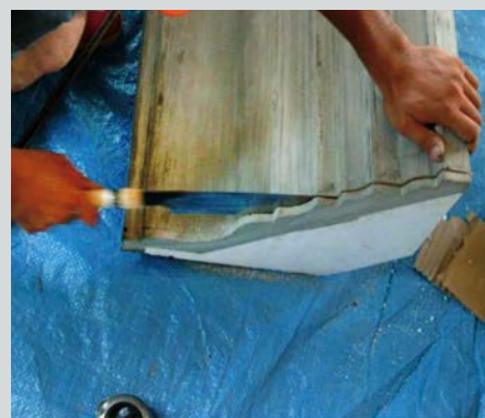
下地に対する取付状況。現場合わせが必要な時でも鋸で簡単に切断できます。
