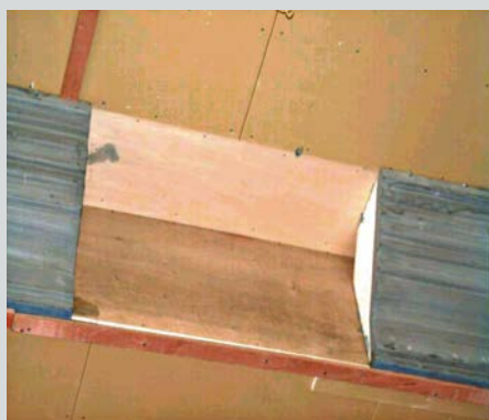
下地に対する取付状況。現場合わせが必要な時でも鋸で簡単に切断できます。
