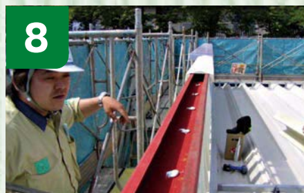
8 笠木の下地材をビスで固定します。固定部には止水コーキングします。
