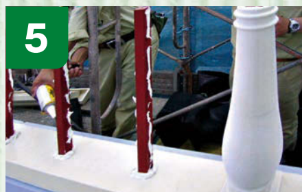
5 欄干のピン下地材に専用ボンドを塗布します。
