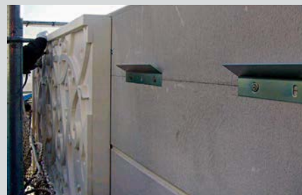
製品の取付けにビスを併用しました。
