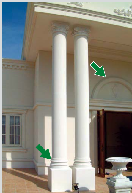
屋根ボーダー(ディンテル付)、勾配部と水平部の取り合いは、型枠では困難です。
