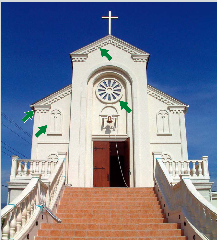
屋根ボーダー(ディンテル付)、勾配部と水平部の取り合いは、型枠では困難です。
