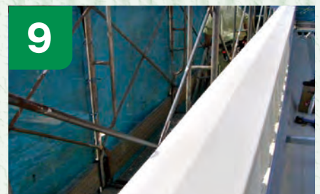
9 笠木を取り付け施工完了です。
