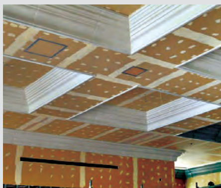
壁と天井の見切りボーダー、飾り天井。 下地に対する取付状況。現場合わせが必要な時でも鋸で簡単に切断できます。
