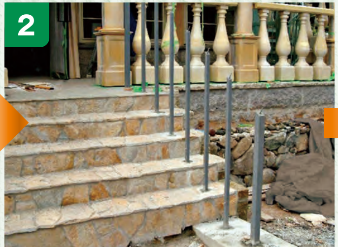
2 手摺子の芯材は、コア抜きした穴に100ミリ程度埋め込みました。芯材天端は、笠木に合せて勾配加工。
