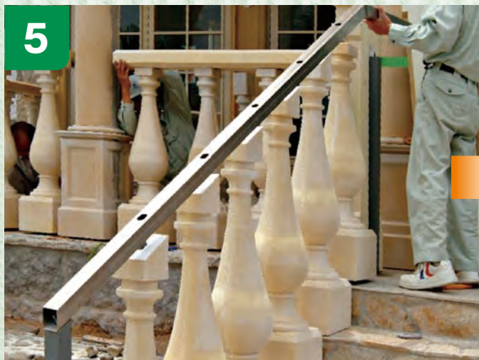
5 笠木の芯材には、手摺子芯材のボルトを通す為に長穴を設けています。
