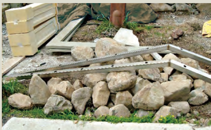
5 笠木の芯材には、手摺子芯材のボルトを通す為に長穴を設けています。
