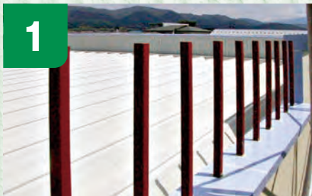
1 欄干のピン下地材です。根元に止水効果のあるコーキングをします。
