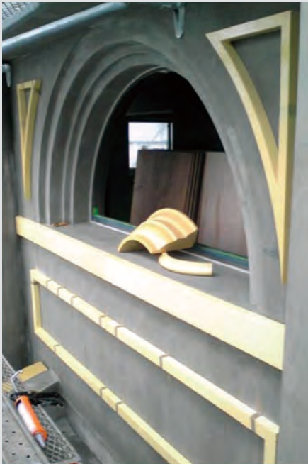
壁面のモール飾り、底部ボーダーの取付け画像です。製品同士の取り付け部にシーリング目地を設けます。
