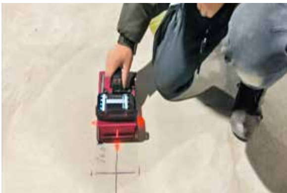
鉄筋探査/X線透過検査
