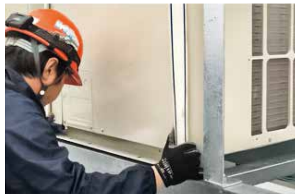
架台設置工事 耐震計算対応可能!
