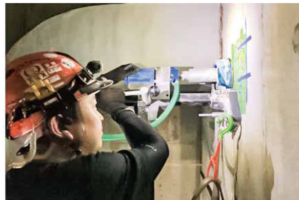
コア抜き工事
