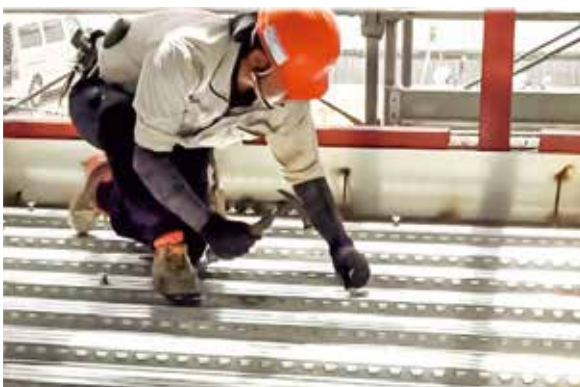
インサート工事「マルインサート」
