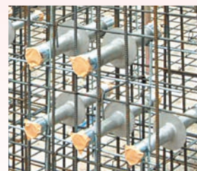
電線管スリーブ施工例
