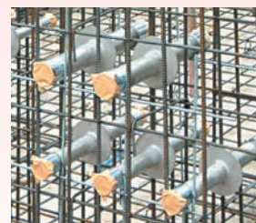
電線管スリーブ施工例
