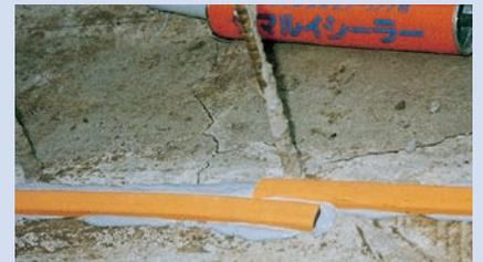
施工前にコンクリート面のゴミ、油、レータンスを充分取除き、マルイシーラーMS-301を約φ8～φ10でコンクリート面に押し付ける様に塗布して下さい。「マルイシーラーMS-301」の上でオレンジシールを置き、約300～500mm程度の間隔でコンクリート釘にて固定して下さい。オレンジシールの接合は最低100mm以上横にオーバーラップさせてマルイシーラーを塗布して下さい。
