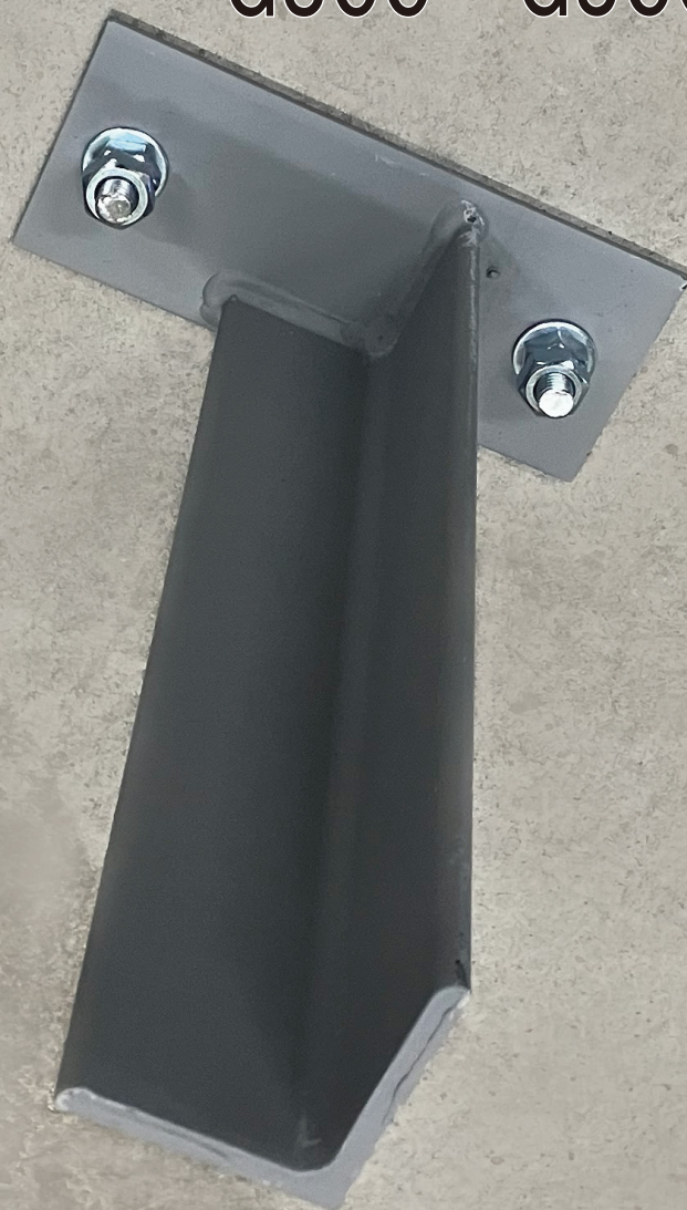
施工例② 壁からの横引き配管の支持
